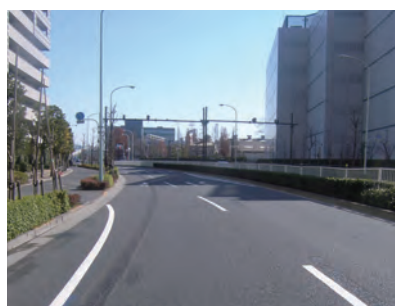
道路拡幅に伴う区画線切換え
