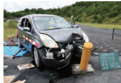
クルマの衝突を受け止め基礎の割れや大きな転倒はありません
