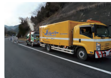
■超高压水表面処理工法 リムーバー
