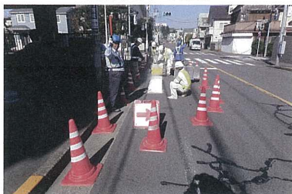
自転車ナビマーク施工中
