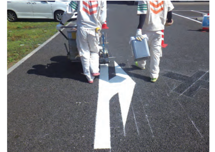
溶融式矢印施工状況
