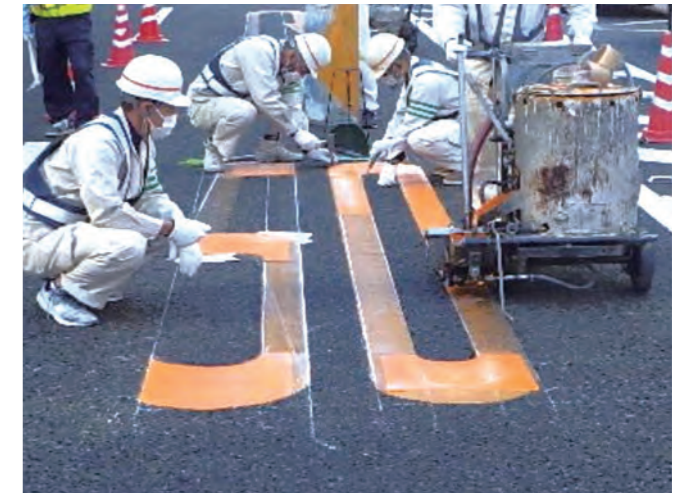
溶融式文字施工状況
