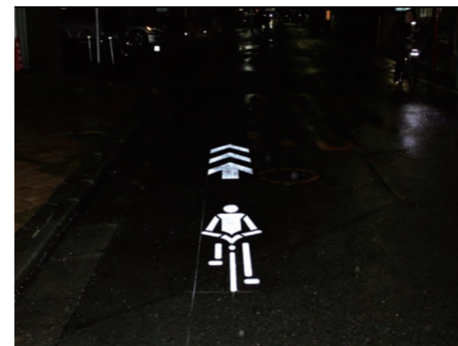
全天候型路面標示 (ナビマーク)
