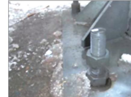
設置後1年程度のアンカーボルトのゆるみ
