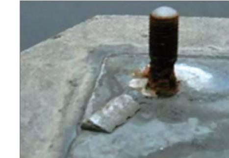
転用部材のアンカーボルトの変状
