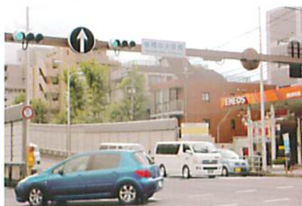
板橋中央陸橋
