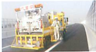
排水性舗装に「ミストライン」作業の安全性向上(中型自走施工機)
