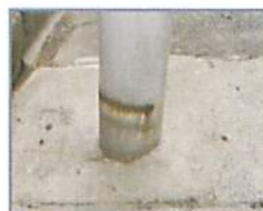
曲げ変形による局所的な腐食による発錆(評価9)
