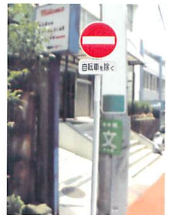
使用環境に応じた標識柱 ● ピカアンドクリーンボール (高視認性、貼紙防止) ● ソルトバリアボール(塩害対策) ● グランドバリアボール(地際防食)
