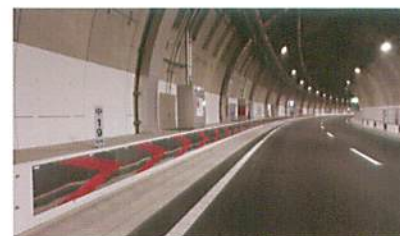
当社施工・首都高山手トンネル
