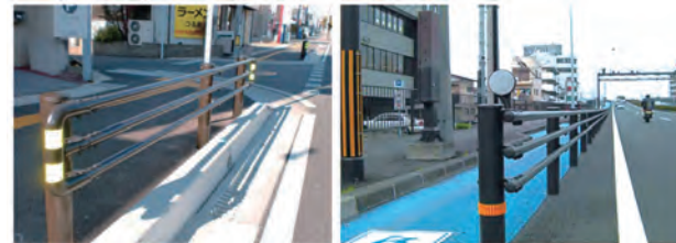
ガードパイプ
