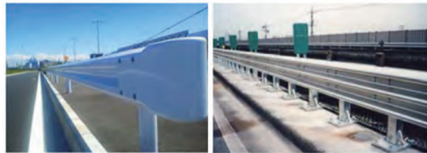
ガードレール
