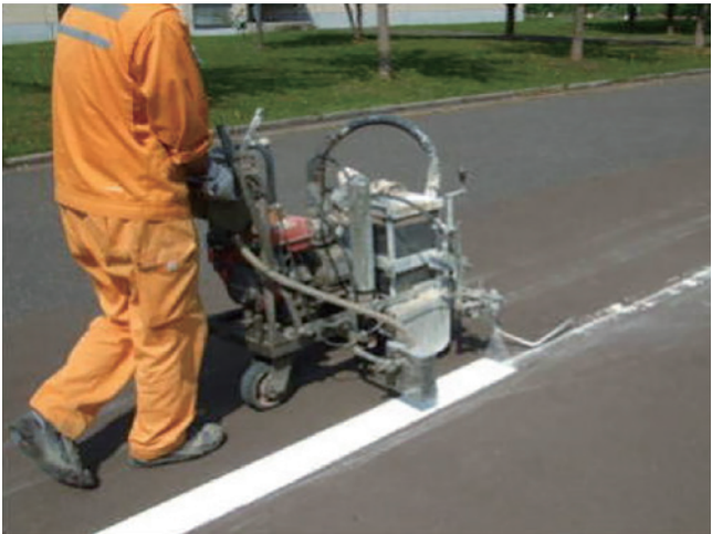
手押しエアレスラインマーカー(常温)
