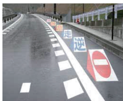
国道178号線 岩美道路 岩美IC~浦富IC 施主: 鳥取県 鳥取県土整備事務所
