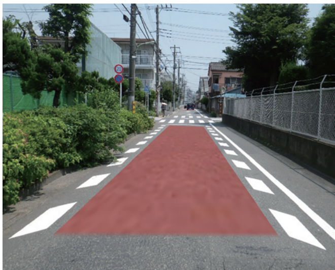
イメージ② すべり止め舗装と減速ドット
