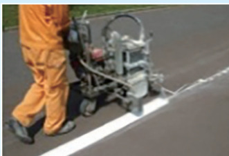
ハンドマーカーク工法 (エンジン式・手押しエアレスラインマーカーク)
