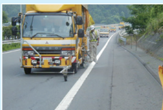
マーカーク工法 (車載式エアレスラインマーカーク)
