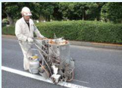
スリット工法 (手押し式-エンジン式を含む-)
