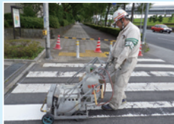
スリット工法 (手引き式)
