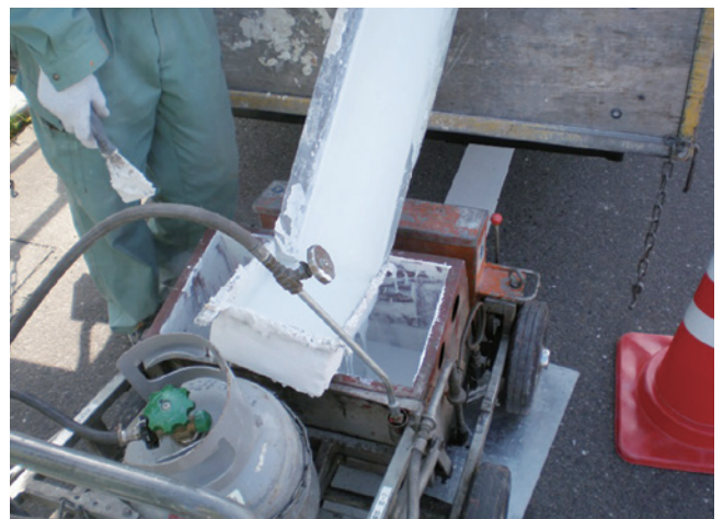
材料投入状況
