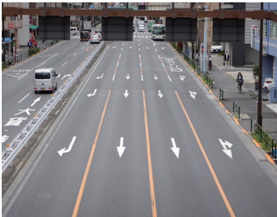
北本通り(国道122号線):宮堀交差点手前
